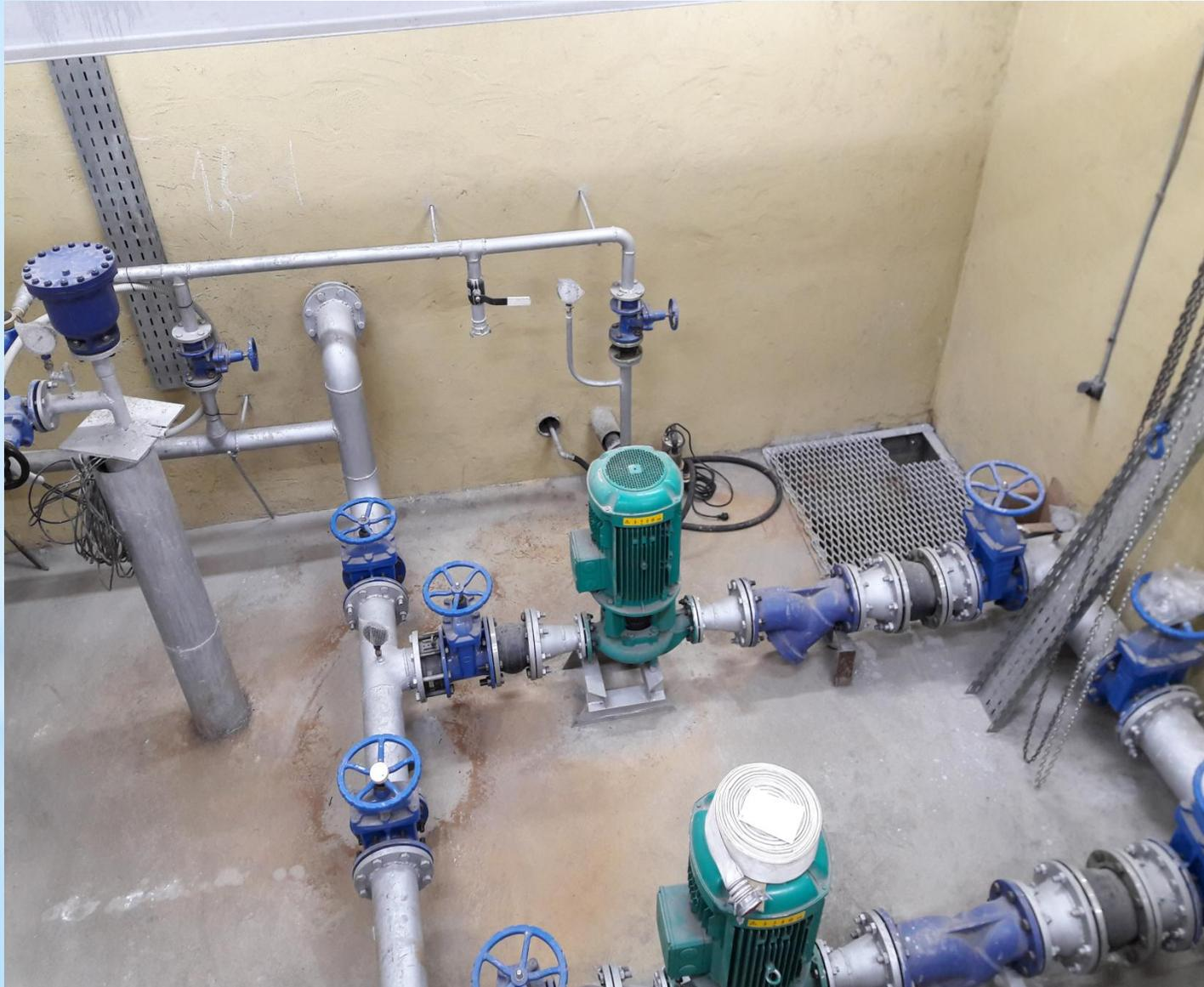
Фото 4. В насосной станции расположена водозаборная скважина, грузоподъемное оборудование, насосная установка, оборудованная клапанами, задвижками, приборами учета
