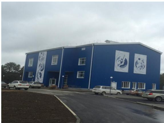
**Замечания : ООО «Ново-Строй», стоимость 114 469,5 тыс. рублей, объект функционирует, не представлена (отсутствует) система осушения воздуха, высокая влажность, отсутствие оборудования (приточная установка)**
