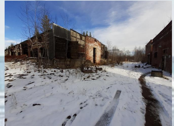
Здание насосной ЦОС
